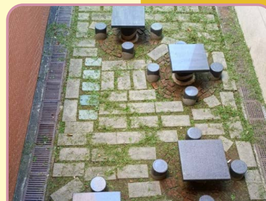
棋藝區整面透水 鋪設
