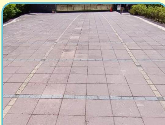
正門愛奇兒廣場 整面透水鋪面
